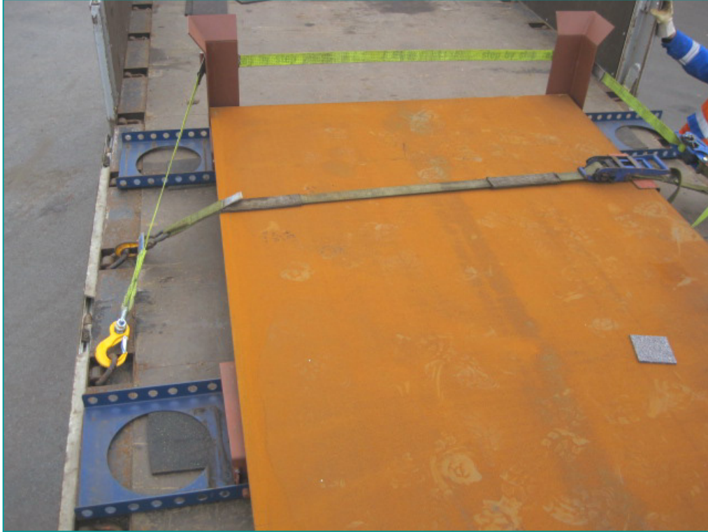
Stahlplattentransport auf Konsolen.
